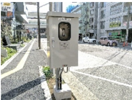
図—1 現場盤設置状況
