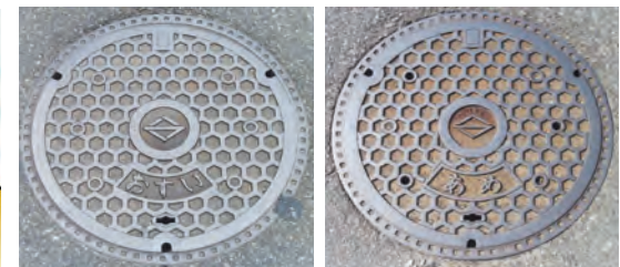
汚水管のマンホール
