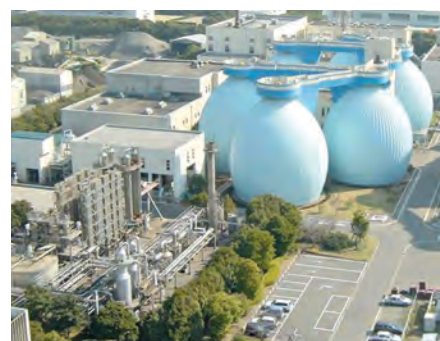
汚泥資源化センター
