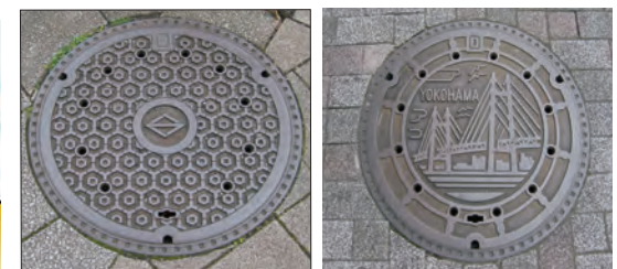
合流管のマンホール
