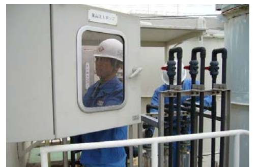
写真-4 PAC注入訓練(11:00)
