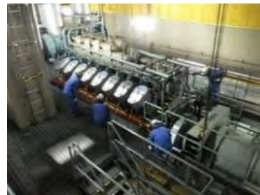
自家発電機設備の点検
