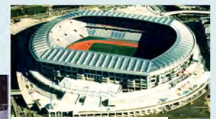
日産スタジアム↑ ←ヒートポンプ
