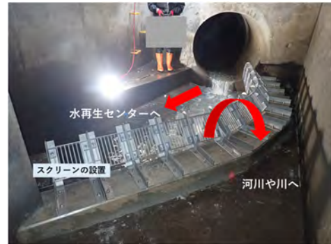
雨水吐の改良状況
