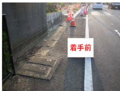
既存コンクリート蓋をグレーチング化した事例 着手前(左) 着手後(右)
