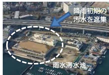
雨水滞水池の整備事例（磯子第二ポンプ場）
