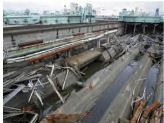
2011（平成23）年 東日本大震災被害状況（施設）
