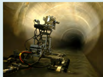
中大口径管の調査状況
