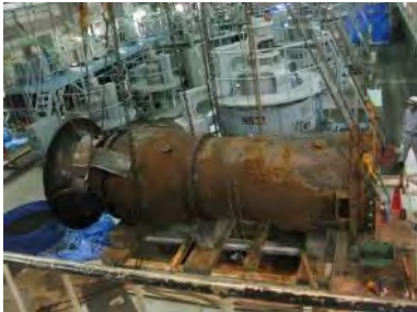
再整備前のポンプ設備
