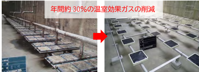
従来型の散気板と最新の散気設備（低圧損型メンブレン）の比較
