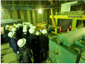
大口径管工事の現場見学会
