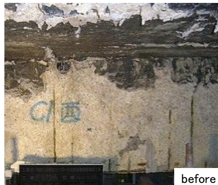
コンクリート表面の補修
