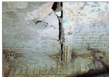
鉄筋が露出した土木施設
