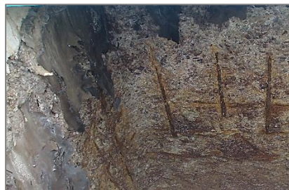
鉄筋が露出した土木施設
