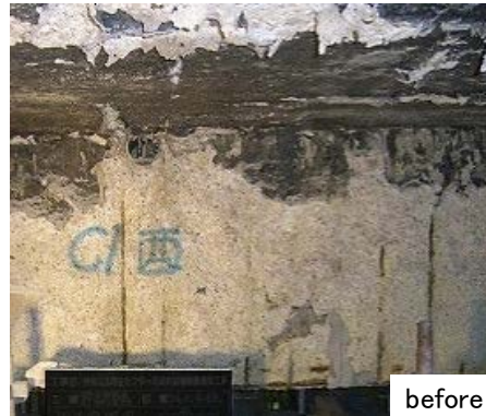
コンクリート表面の補修
