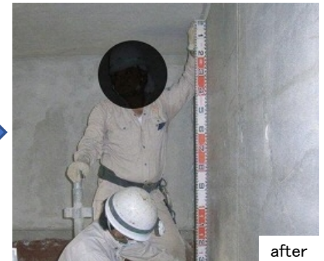
コンクリート表面の補修
