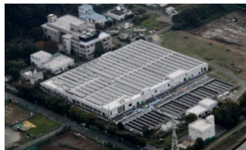
太陽光パネルの設置 (西部水再生センター)
