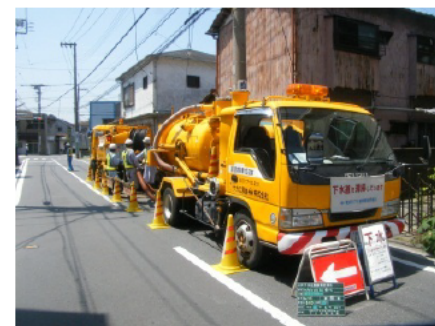
吸引車による下水道管の清掃
