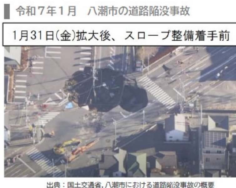
図 2-15 埼玉県八潮市の道路陥没事故
