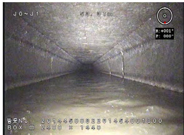
下水道管内の状況(腐食の一例)
