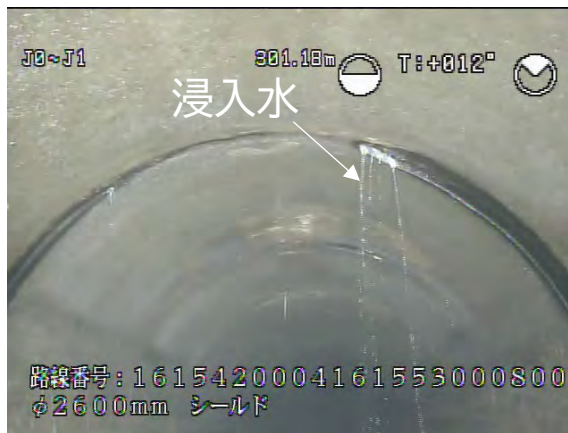
下水道管内の状況(浸入水の一部)
