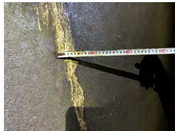
下水道管内の状況(クラックの一例)
