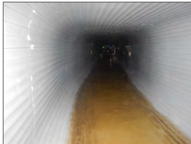
管更生工法による改築の例
