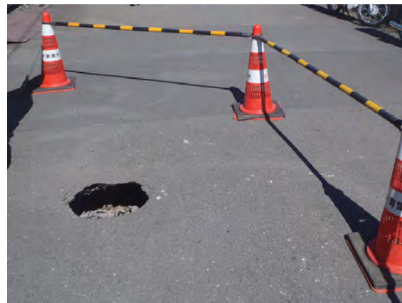
下水道管に起因した道路陥没の一例
