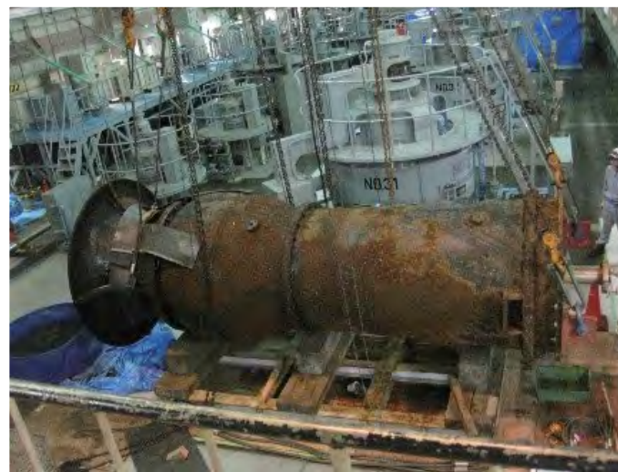
再整備工事のために撤去されるポンプ設備
