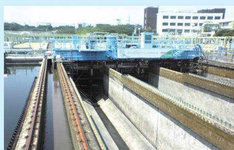
最終沈殿池の採泥機
