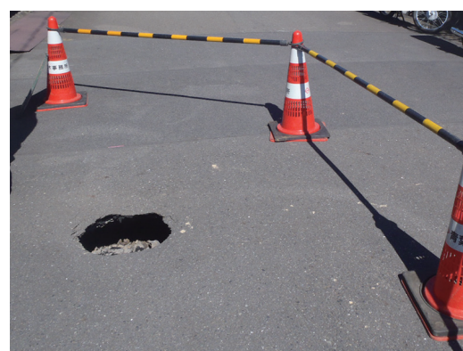
取付管破損による道路陥没
