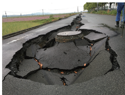
2016（平成28）年 熊本地震被害状況（下水道管）
