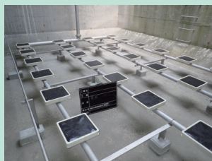
従来型の散気板と最新の散気設備（低圧損型メンブレン）の比較
