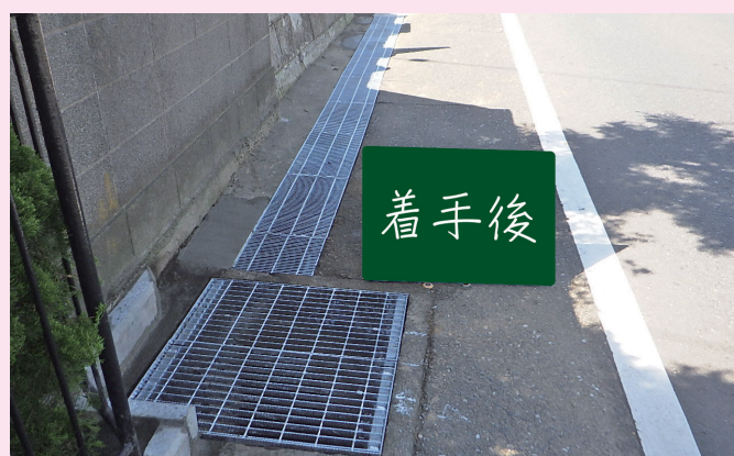
既存コンクリート蓋をグレーチング化した事例 着手前(左) 着手後(右)
