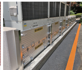
機械設備の耐水化（止水板）
