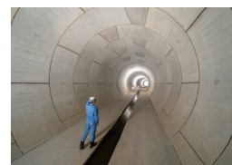
雨水貯留施設(新羽末広幹線)の内部
