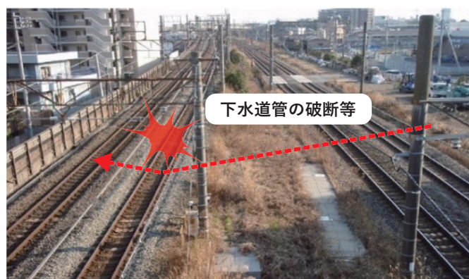
鉄道軌道下の下水道管の耐震化
