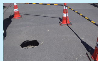
取付管破損による道路陥没
