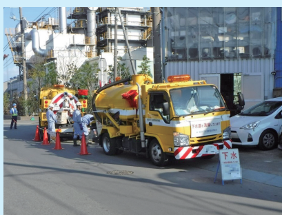
吸引車による下水道管の清掃
