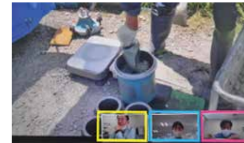
工事現場のリモート立ち会いの様子
