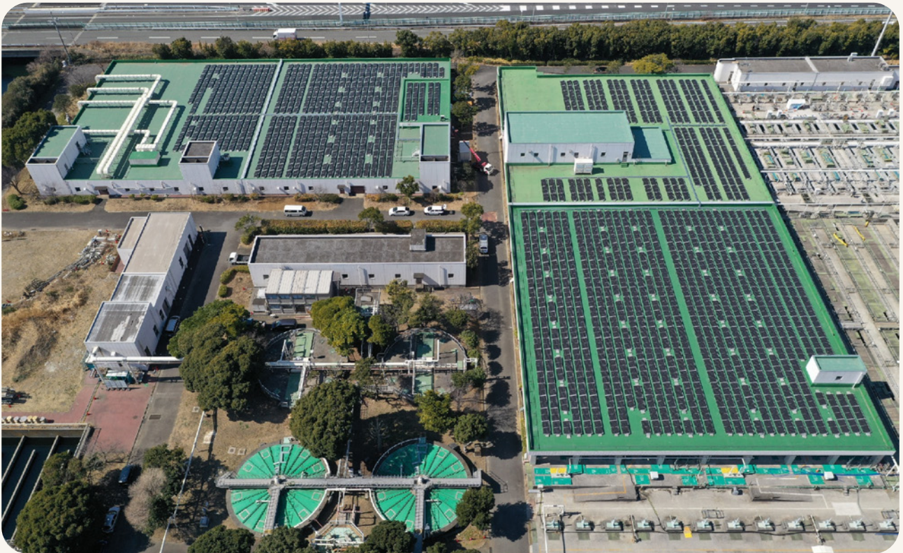
太陽光発電設備（金沢水再生センター）
