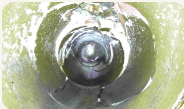
破損した陶管
