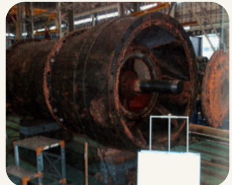
主ポンプ設備の修繕
