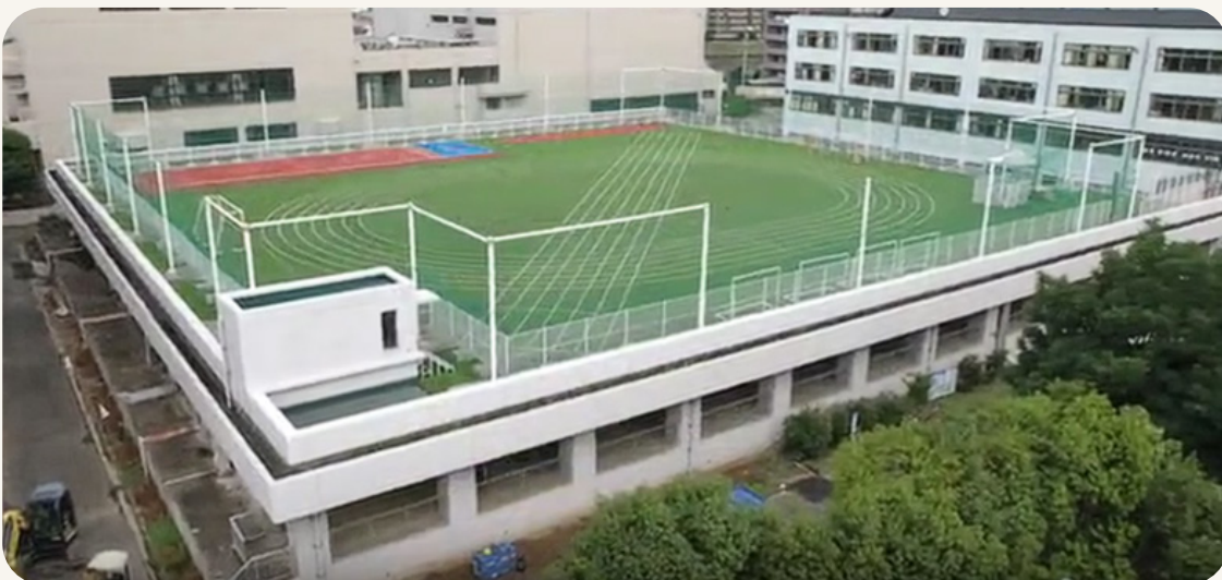
北部第一水再生センターの上部利用(市場小学校けやき分校)
