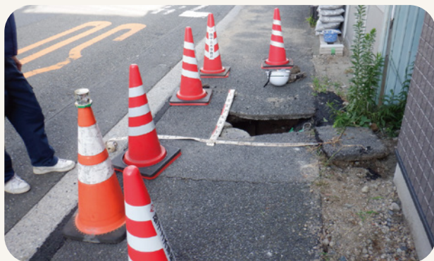
取付管に起因する陥没の状況
