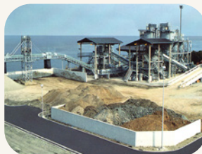
改良土プラント
