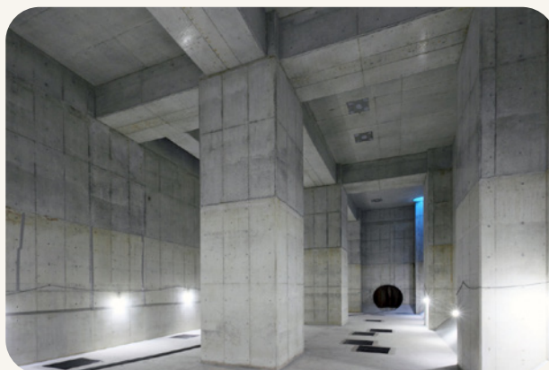
雨水調整池(星川雨水調整池)
