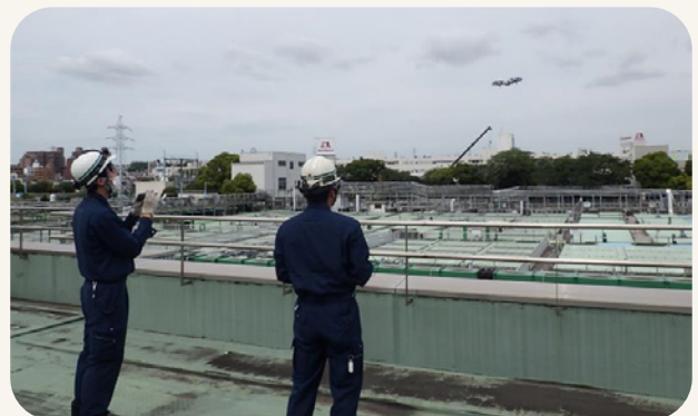
ドローンを活用した点検
