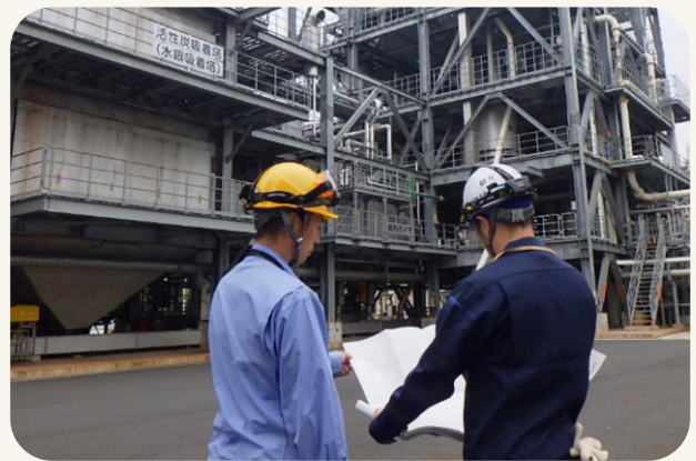
修繕工事の発注と監督
