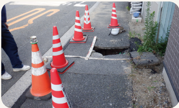
取付管に起因する陥没の状況
