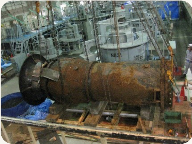
再整備前のポンプ設備
