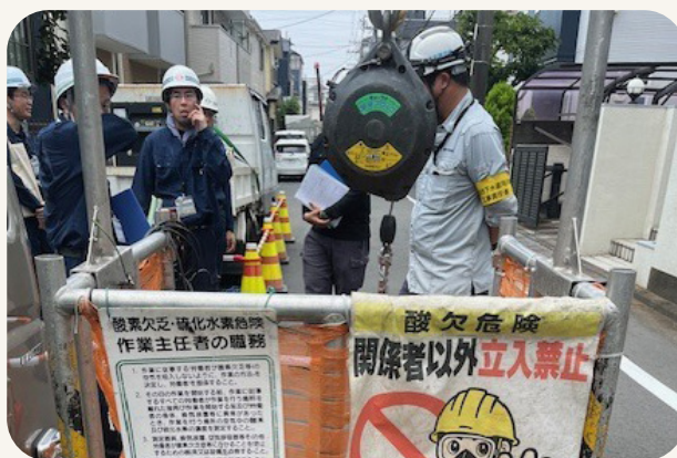
現場点検状況
