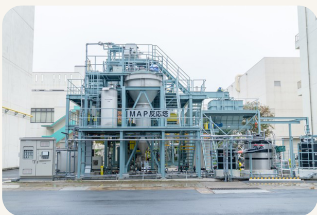
リン回収施設
