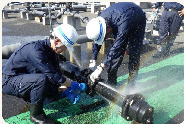
水道局漏水修理体験型研修
