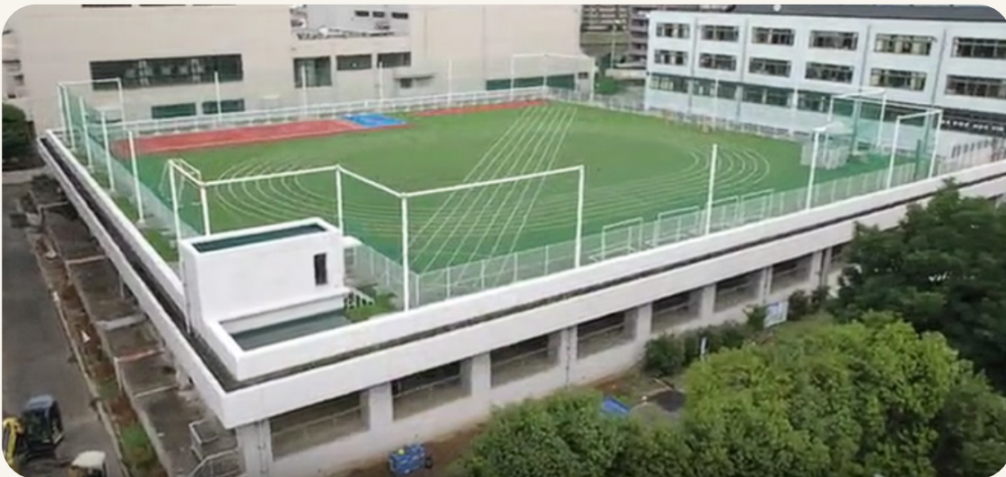
北部第一水再生センターの上部利用(市場小学校けやき分校)
