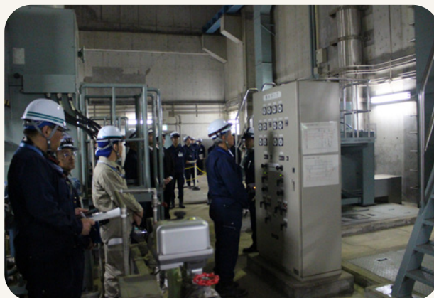
水再生センター等の災害対応訓練
