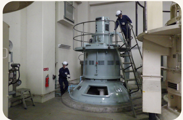
主ポンプ設備の点検
