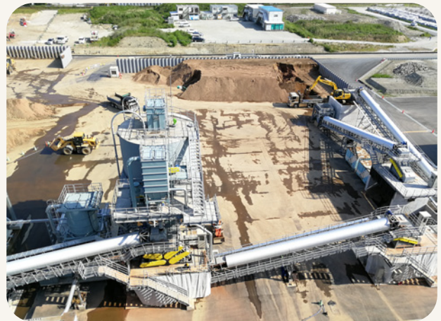
改良土プラント
