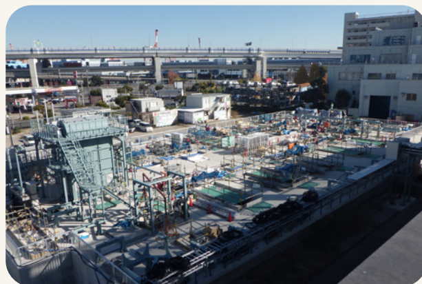
高速ろ過施設施工中の様子(中部水再生センター)
