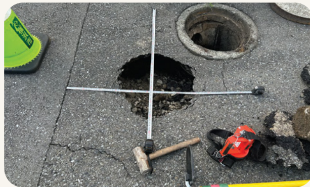
取付管に起因する陥没の状況
