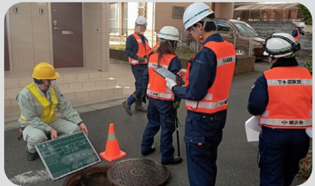
下水道管実地調査訓練
