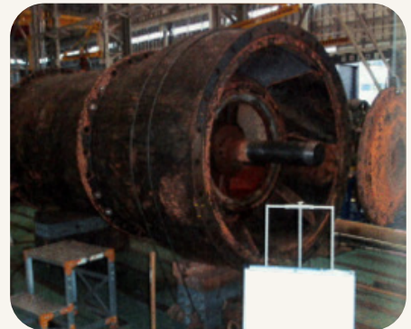
主ポンプ設備の修繕
