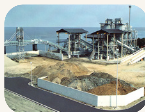
改良土プラント
