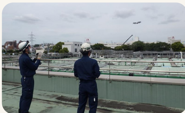
ドローンを活用した点検
