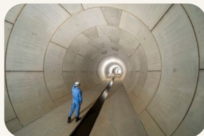
雨水貯留施設(新羽末広幹線)
