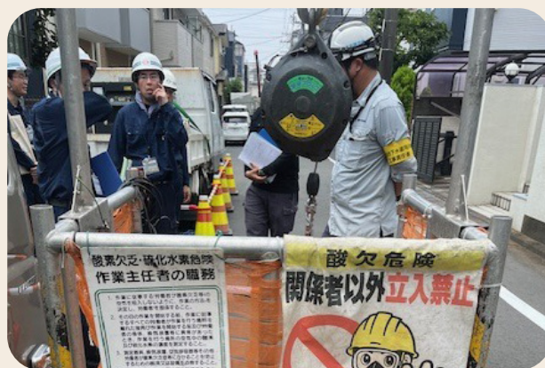
現場点検状況
