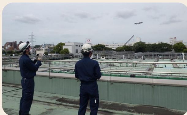
ドローンを活用した点検
