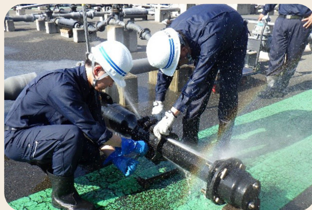
水道局漏水修理体験型研修
