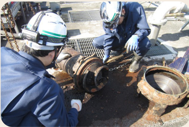
点検・修繕（ストックマネジメント）
