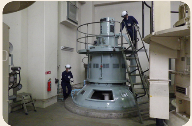
主ポンプ設備の点検
