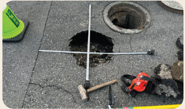
取付管に起因する陥没の状況
