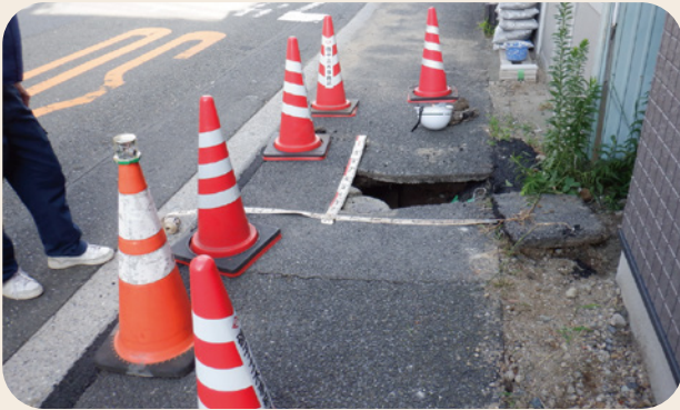
取付管に起因する陥没の状況
