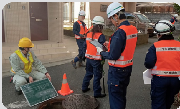
下水道管実地調査訓練
