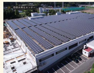
▲施設上部を利用して発電した電気は、電力会社へ売っています
