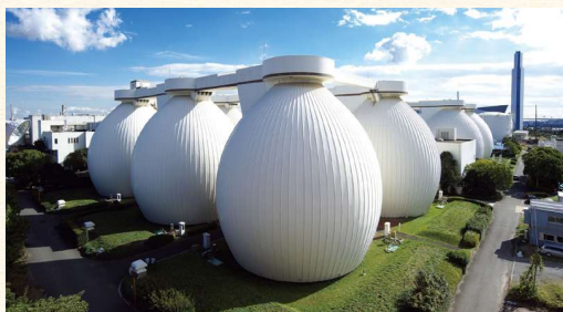
▲汚泥資源化センターの消化タンク
