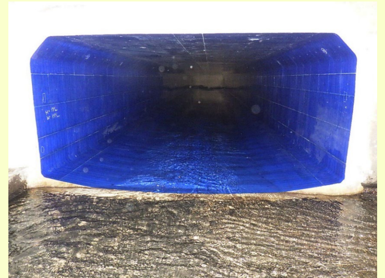
管きょ更生工（施工完了） （2工区）
