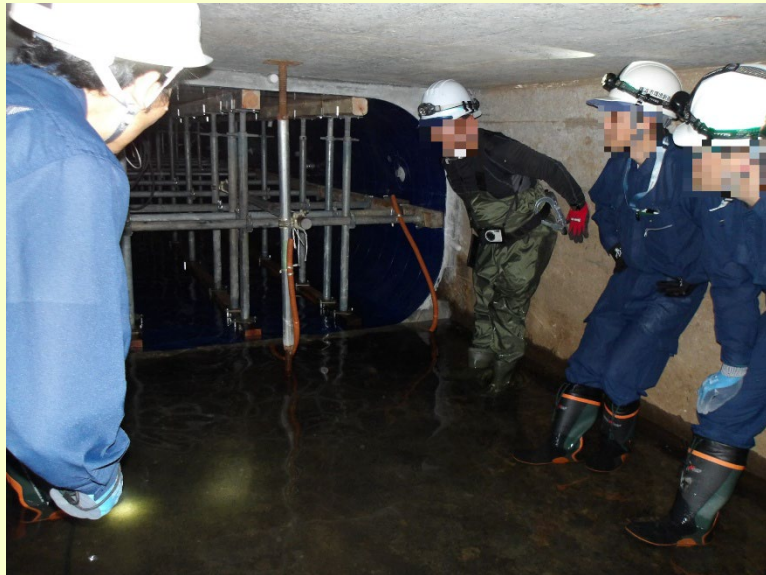
施工状況確認
