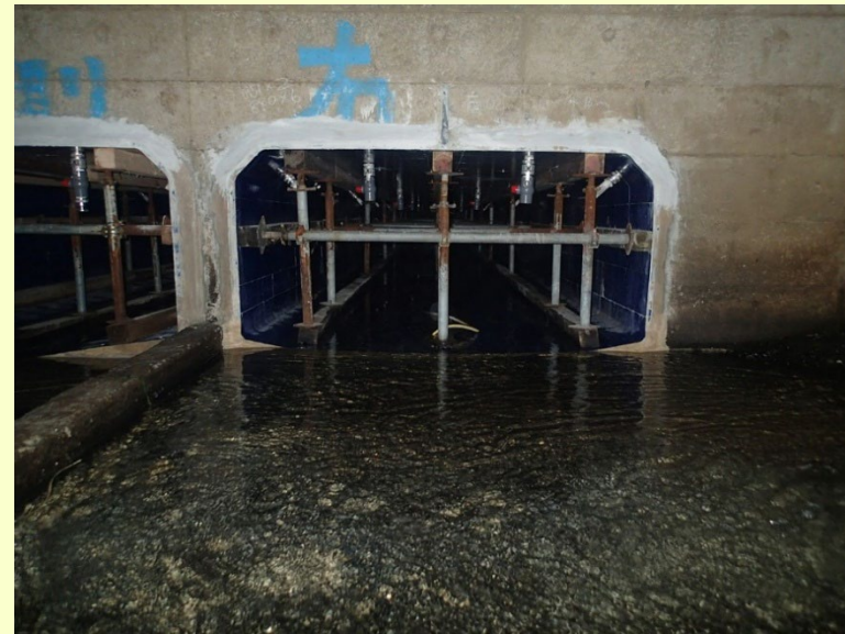
管きょ更生工（施工中）
