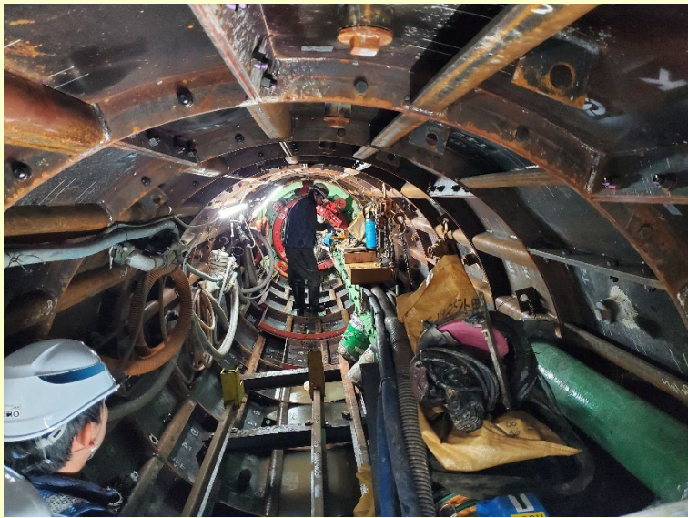
セグメント組立状況
