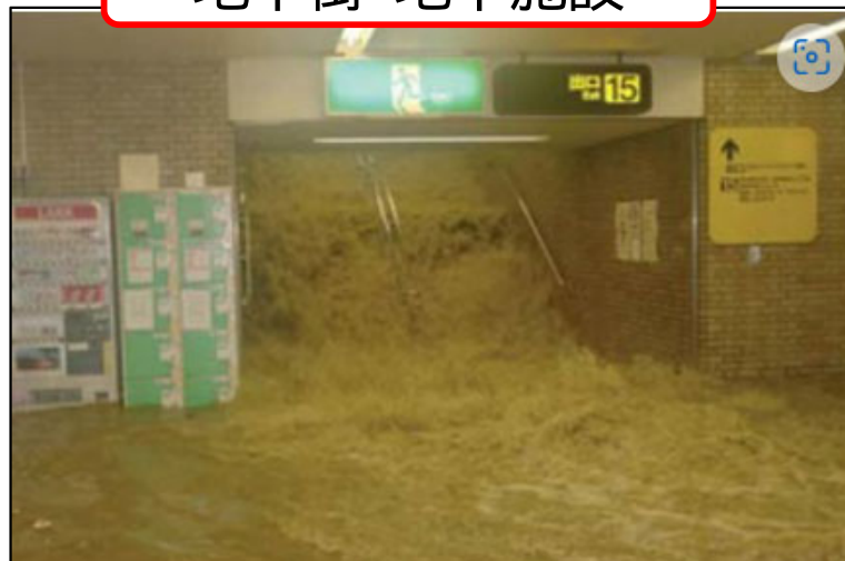
出典:福岡市HP(地下街への雨水流入 平成11年)
