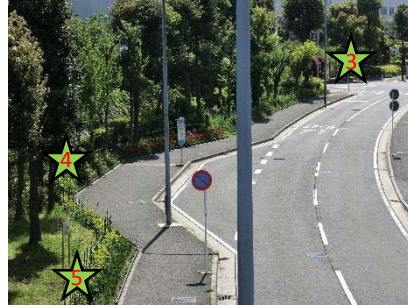
整備ポイント3,4,5の現状 ポイント3: エリアマップ憩いコーナー ポイント4: 山田小 花植え緑地 ポイント5: 東山田小 花植え緑地
