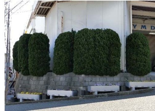
(注) 平成30年12月中旬、プランター設置・緑化整備工事完成
