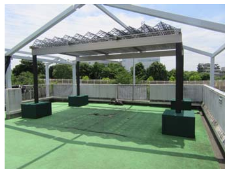
図2 保育園に設置したフラクタル日除け
