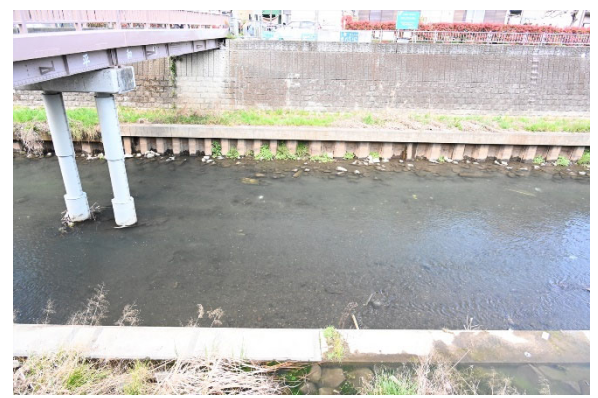
付図 8 帷子川水系帷子川平和橋
