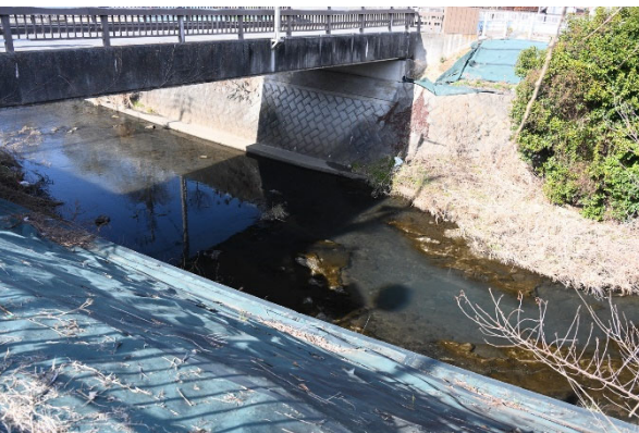
付図 4 帷子川水系帷子川今川橋
