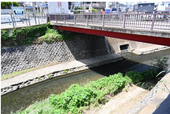
付図 10 大岡川水系大岡川青木橋
