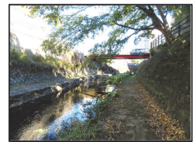
⑥ 大岡川青木橋
