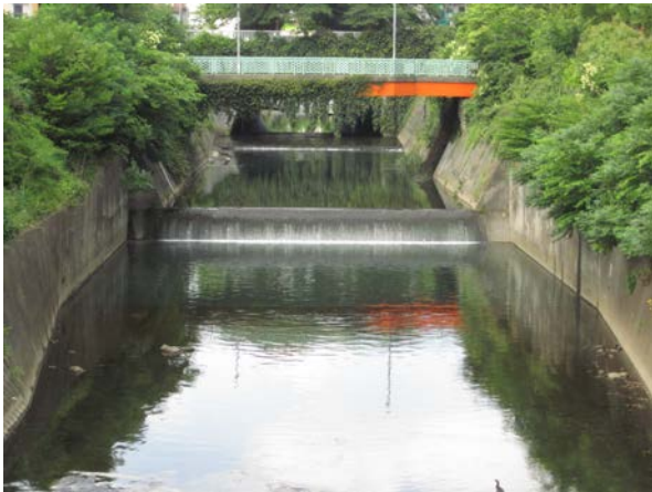
写真-1 水道橋上流、魚道のない落差工
