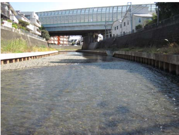
写真-8 平和橋と新道下 (ST. 8) の産卵場、 200m 下流は感潮域
