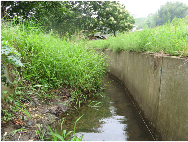
写真-6 BRの観察区、ST. 10 写真下に簡易堰、水路出口
