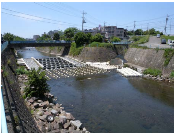
写真-2 魚道が設置された落差工 (ST. 5、島越橋)
