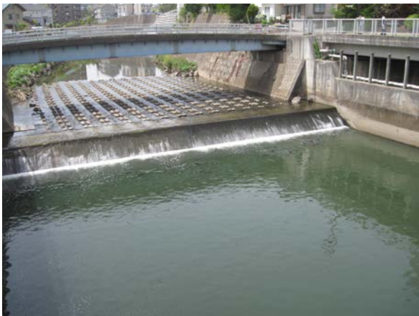
写真-3 分水路の上端の落差工 (愛宕橋)
