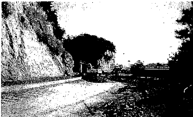
▲写真3 整備前(へドロ浚せつ後)
