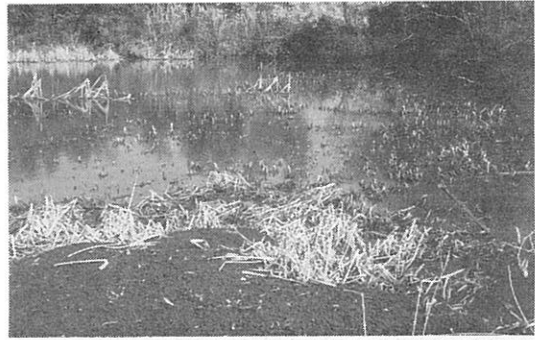
写真-16 地区3号公園池に造成された斜面 の土砂が流入して堆積した状況 (1987年1月)
