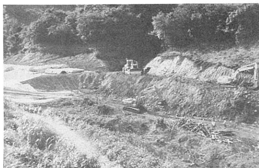
写真-2 氷取沢・金沢自然公園付近写真-1の下流における基礎的地形整備の進行(1987年10月)
