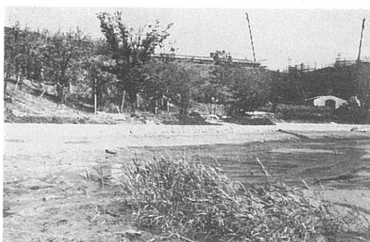
写真-20 鴨池公園造成に伴う池の水抜き (1983年5月)
