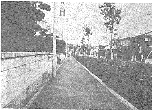
写真Ⅲ-22 住宅地区 （植樹帯の高さ 1.0m）
