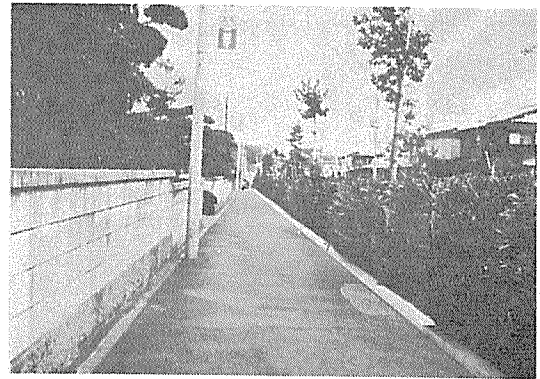
写真Ⅲ-23 住宅地区 （植樹帯の高さ 1.5m）
