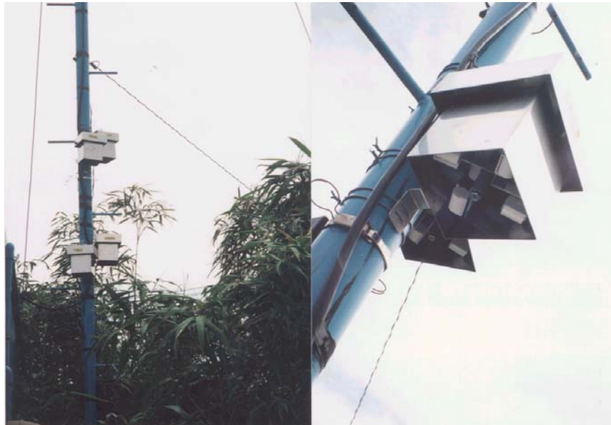
図4 シェルターと短期暴露用拡散型サンプラーでの測定の様子
