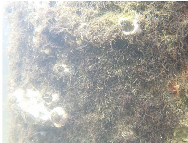
写真 7.1 ホソアヤギヌ着生基盤（鋼矢板）と着生状況（冬季）
