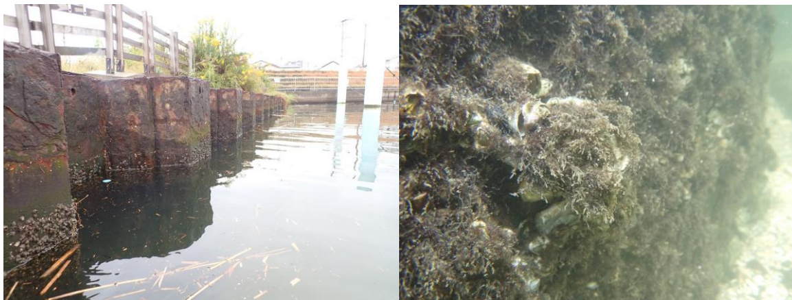
写真 7.1 ホソアヤギヌ着生基盤（鋼矢板）（左）、着生状況（右）
