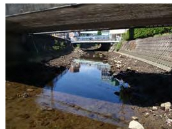
侍従川 六浦二号橋
