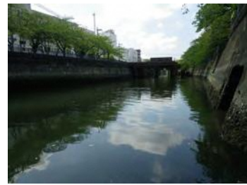
大岡川 井土ヶ谷橋
