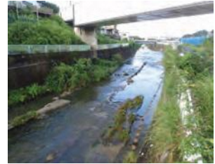
恩田川 堀の内橋
