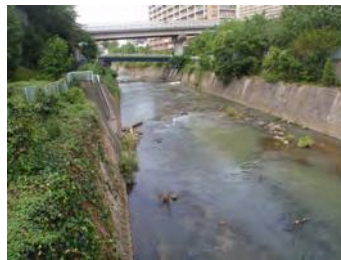
帷子川 鶴舞橋
