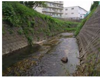
大岡川 曲田橋
