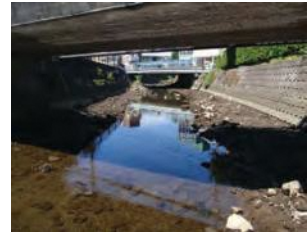
侍従川 六浦二号橋
