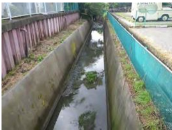
帷子川 大貫橋上流
