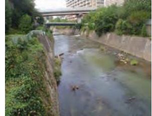
帷子川 鶴舞橋
