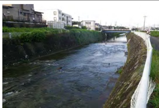
T7 鶴見川・恩田川 堀の内橋
