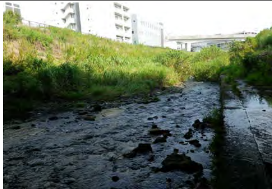
T5-2 鶴見川・早湊川 境田橋
