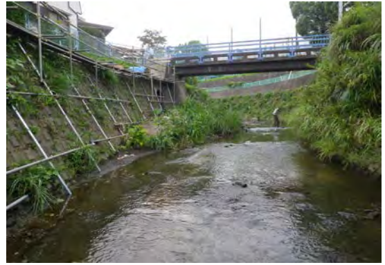
○3 大岡川 曲田橋
