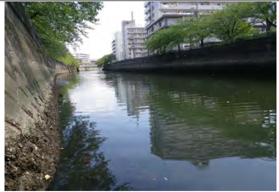
○4 大岡川 井土ヶ谷橋
