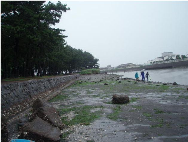
写真4 (17) 野島水路全景 (1)
