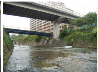
帷子川 鶴舞橋
