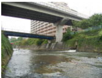
帷子川・鶴舞橋
