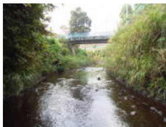
大岡川・曲田橋
