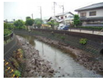
侍従川・六浦二号橋
