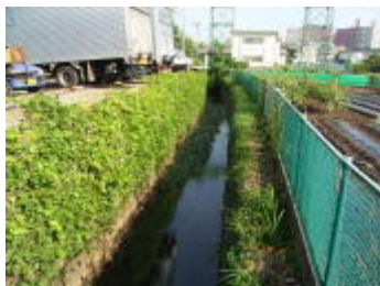
帷子川・大貫橋上流
