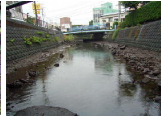
侍従川 六浦二号橋
