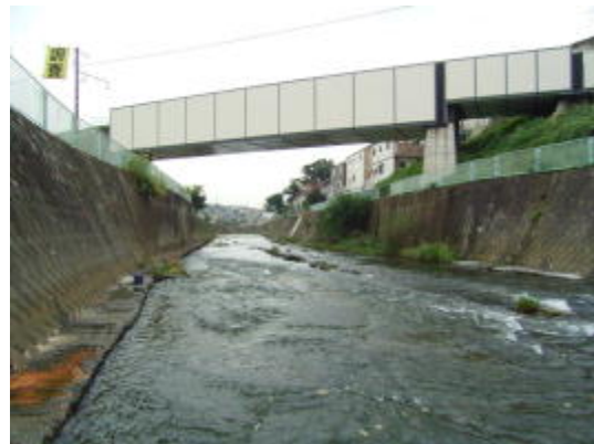
T7 鶴見川・恩田川 堀の内橋
