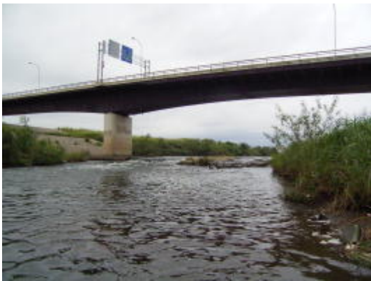
T4 鶴見川 亀の甲橋
