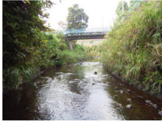
○3 大岡川 曲田橋
