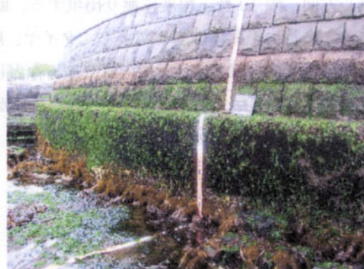
岸壁調査地点 (石積み護岸)
