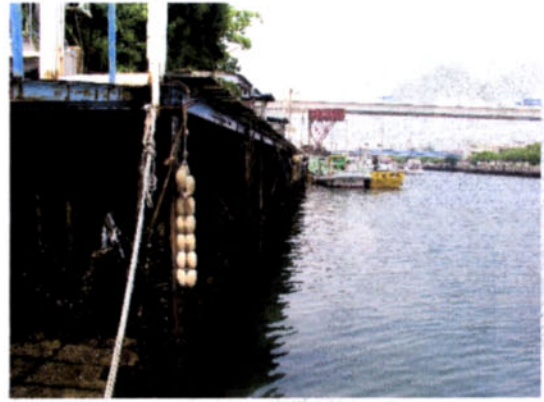
栈橋の下 鋼矢板
