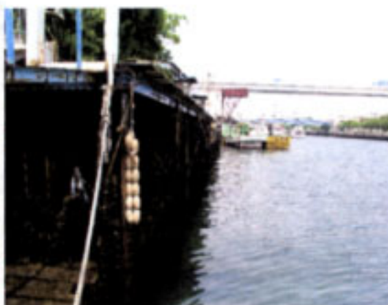
栈橋（鋼矢板で護岸される）
