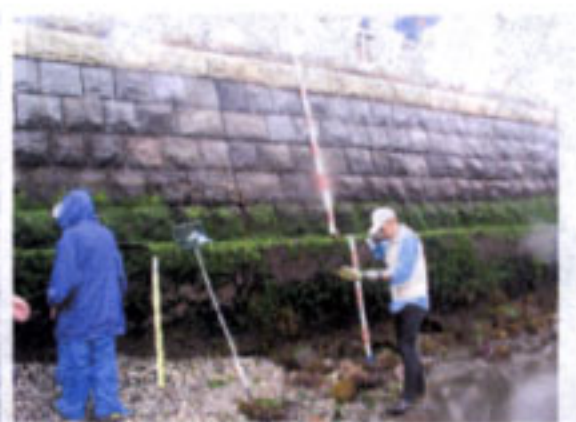
Ⅱの岸壁調査地点（石積み護岸）
