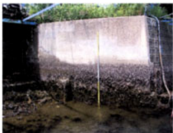
岸壁調査地点
