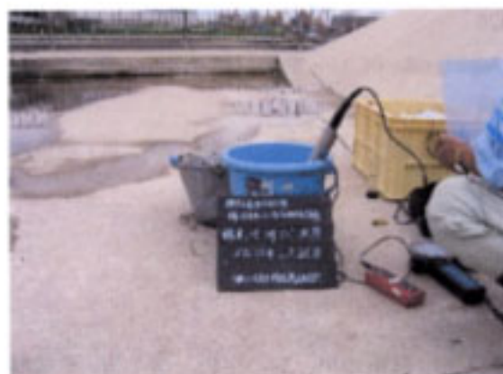
現場環境測定
