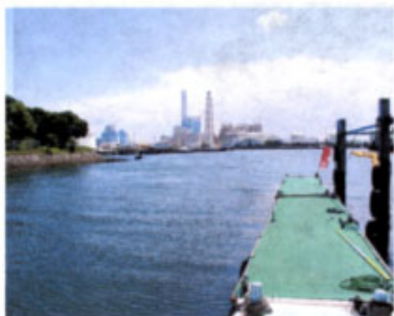
掘割川河口調査地点全景
