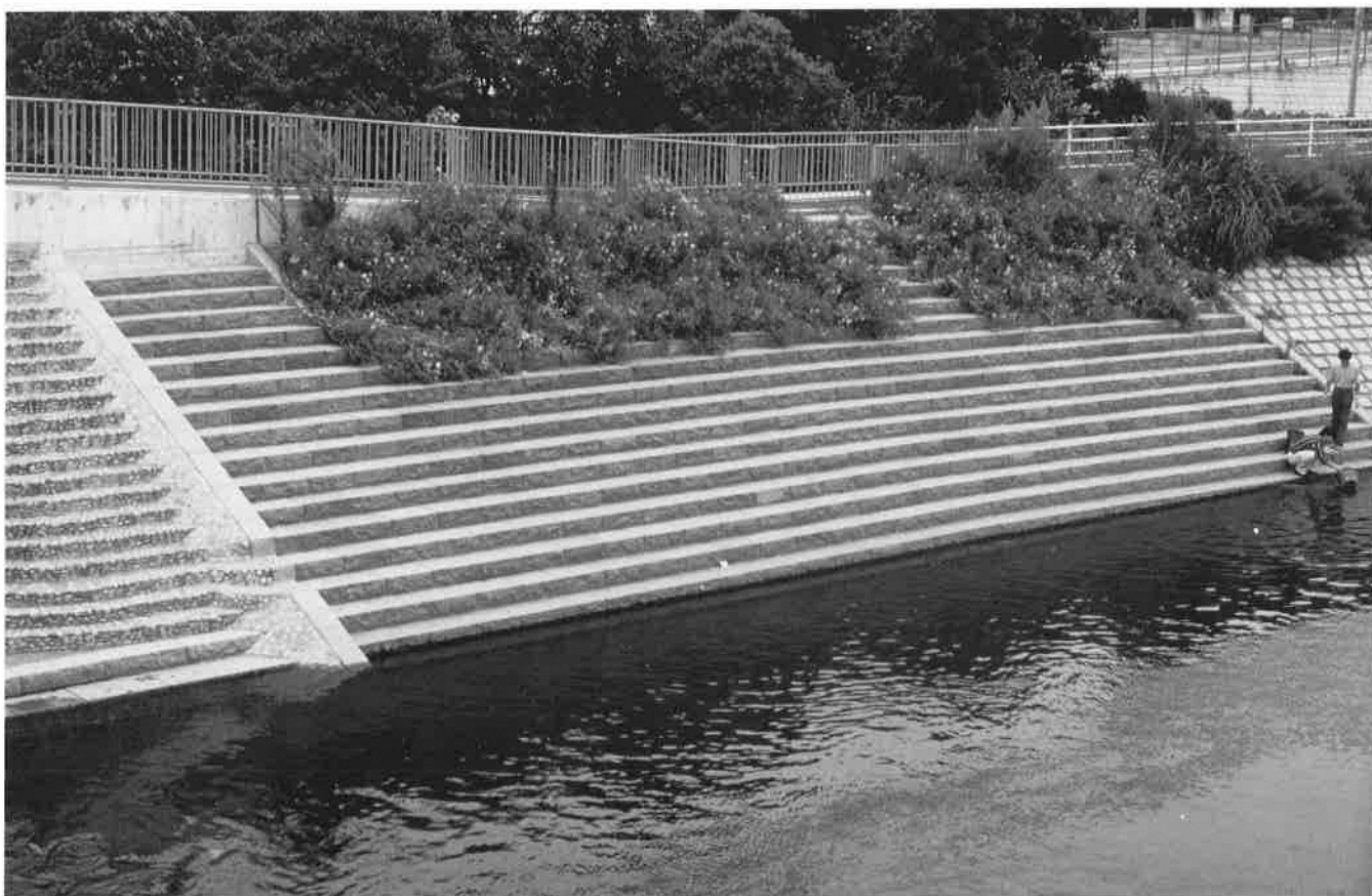
写真一 4 親水護岸によって園芸種の生育地となった堤防法面（境川中島橋）
