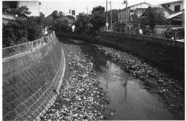
J 2 侍従川 六浦二号橋
