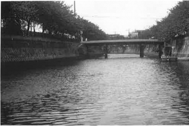
○4 大岡川 井土ヶ谷橋
