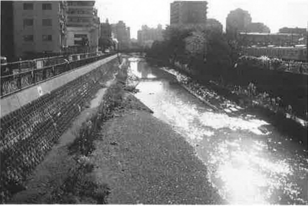
K 4-3 帷子川 星川橋
