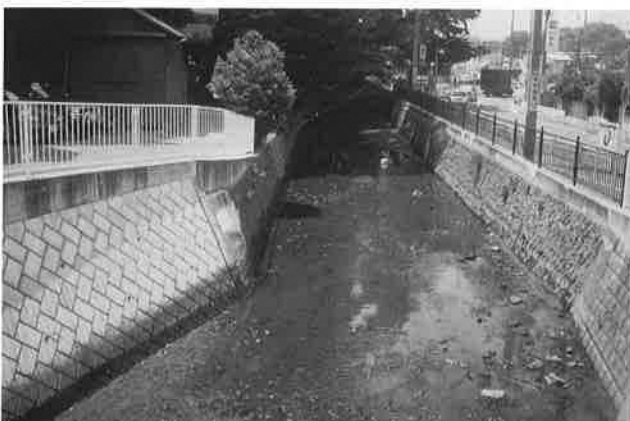
M2 宮川 宮川橋
