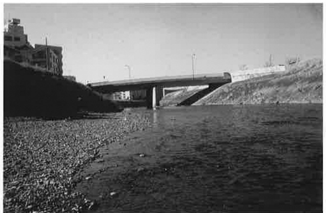
T 8 鶴見川・恩田川 都橋
