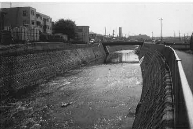
T 7 鶴見川・恩田川 堀の内橋
