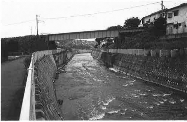
T 7 : 鶴見川・恩田川・堀の内橋
