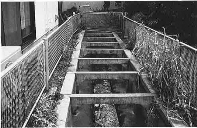
K 5 : 帷子川・今井川・根下橋上流
