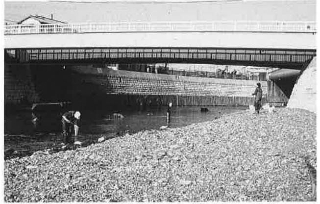
K 4 - 3 : 帷子川・星川橋
