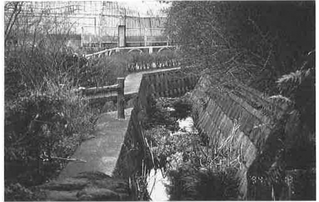
M3：宮川・清水橋上流
