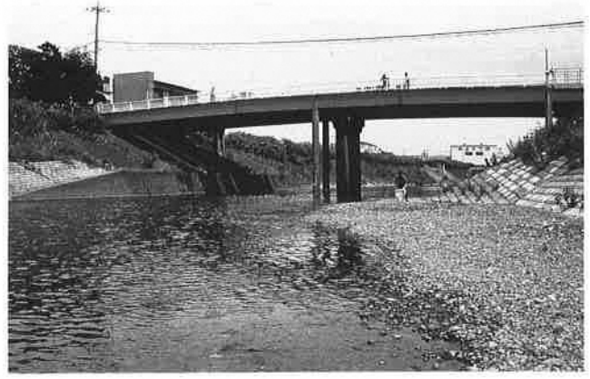
T 8 : 鶴見川・恩田川・都橋
