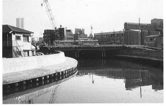
K 4 : 帷子川・水道橋
