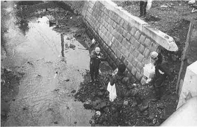
M2：宮川・宮川橋
