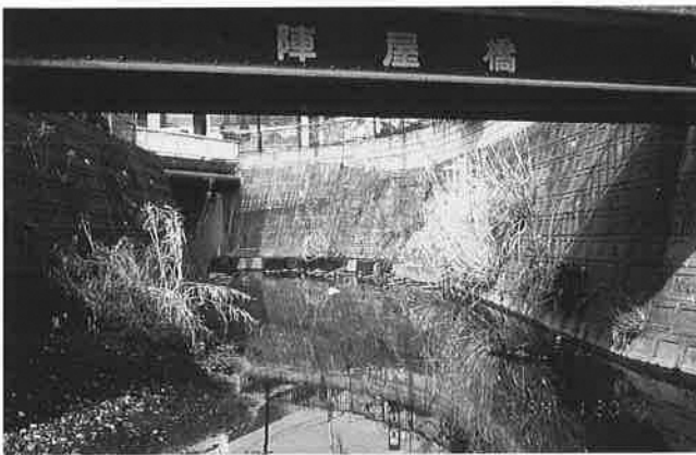
0 2 : 大岡川・陣屋橋
