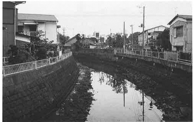
J2：侍従川・六浦二号橋
