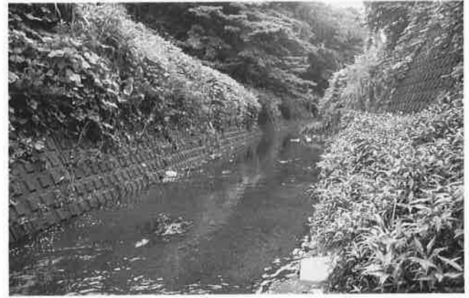
0 3 : 大岡川・日下橋
