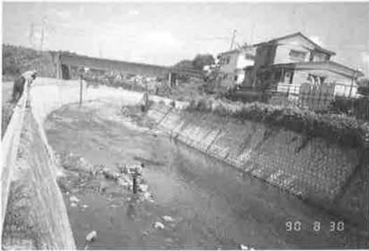
T 7 ; 支流, 恩田川の堀の内橋
