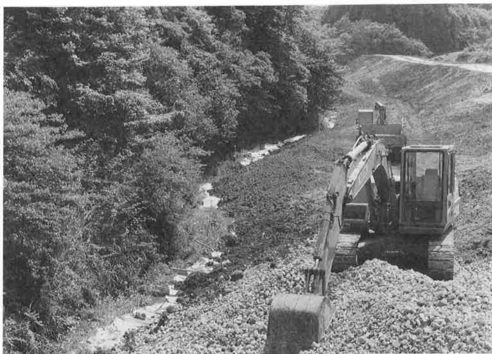
⑧ 造成が進む源流域。この流水辺にはセキショウ群集が広くみられた（緑区台村町;1991/6/1）。
