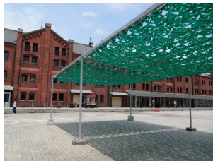
横浜赤レンガ倉庫でのフラクタル日除けの効果検証
