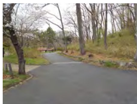
公園での透水性舗装等の整備による雨水の貯留・浸透機能の向上（旭区）
