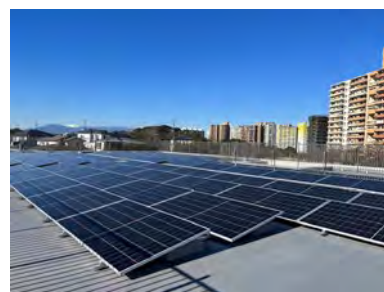
PPA 事業で市立学校に導入した太陽光発電設備
