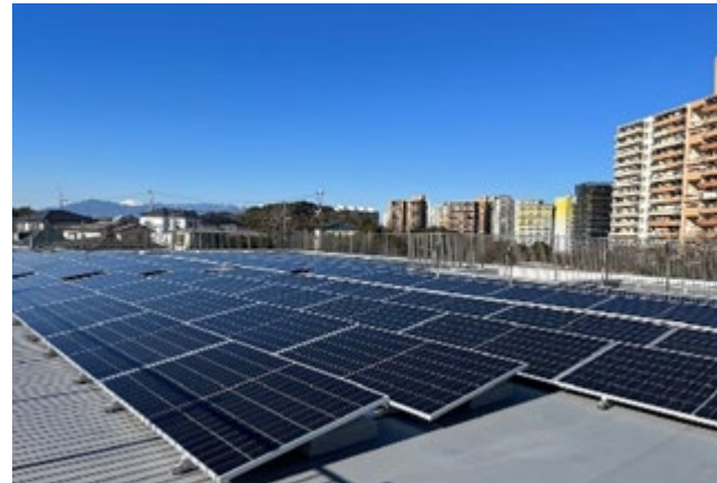
PPA事業で市立学校に導入した太陽光発電設備
