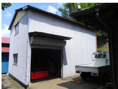
【特定農業用施設の例】 上：農業用倉庫 下：農業用倉庫及び作業場
