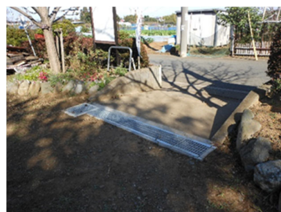
【側溝の整備】 鴨居原市民の森（緑区）
