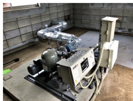
【改修を行ったポンプ施設】（戸塚区）
