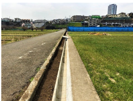
【水路の再整備】（青葉区）
